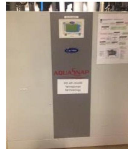
Varmepumper for hhv. Varmtvann og oppvarming. Foto: Skanska
