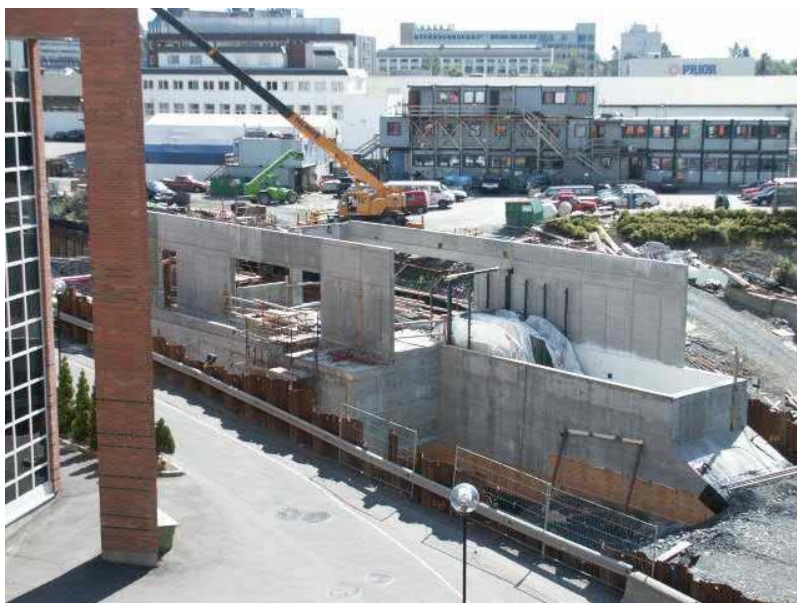
Arbeidet med Nydalen stasjon går sin gang
