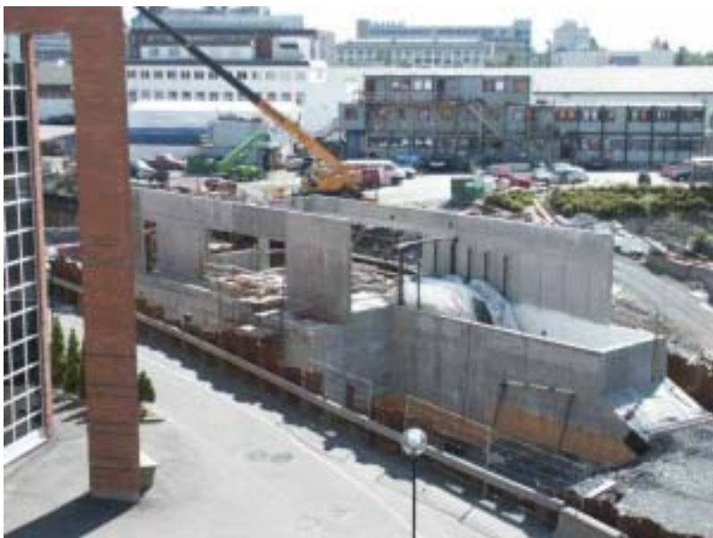
Arbeidet med Nydalen stasjon går sin gang
